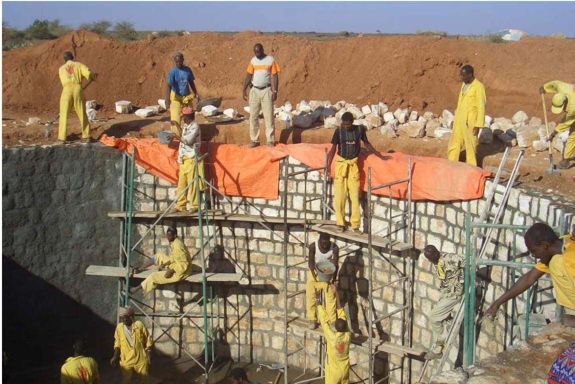
Der Bau solcher Wasserspeicher dient gleichzeitig als Ausbildungslehrgang für Dorfmaurer. Foto: Jakob Strässler
