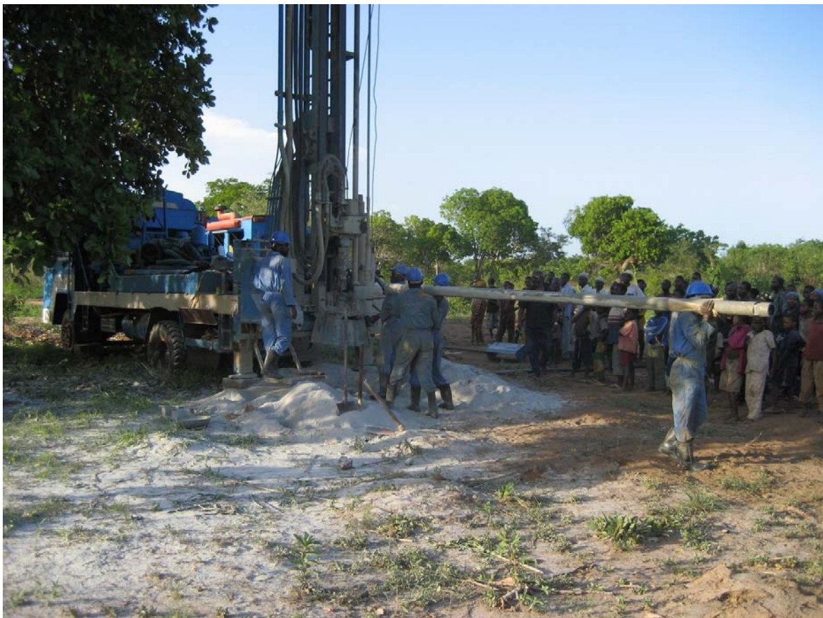
Bohrung in einem Dorf 2008 (Foto: Helvetas Moçambique)
