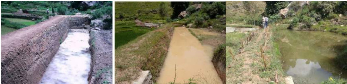
Construction de barrage de retenue en terre à Faliarivo
