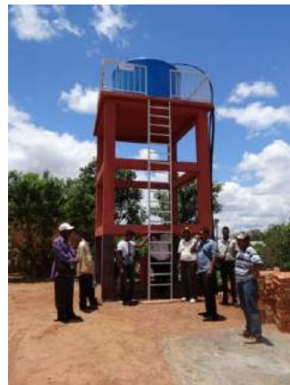
Château d'eau pour le site de nutrition à Masindray
