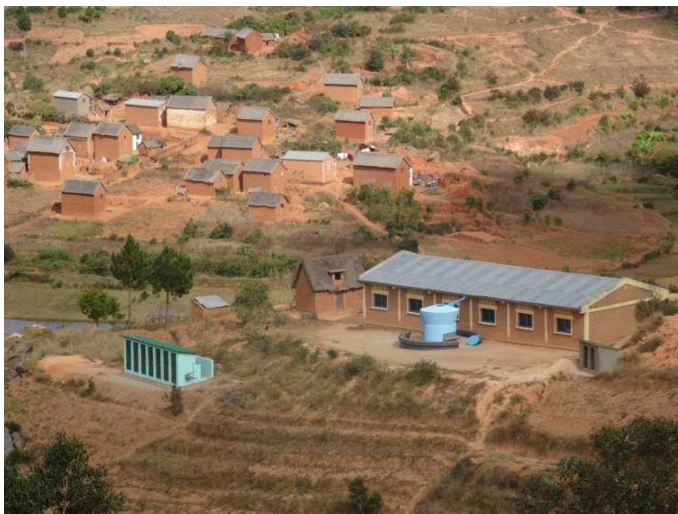
Impluvium et bloc sanitaire à l'école primaire de Faliarivo
