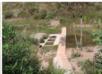
Filtre à gravillon pour traitement de l'eau turbide
