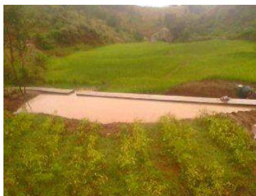
Barrage de captage en béton
