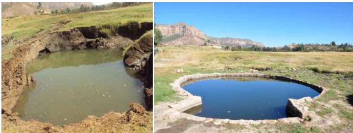
Handgegrabener Brunnen in Akora während dem Aushub und nach der Fertigstellung Ende 2013 (Foto: ADCS/Caritas Schweiz)
