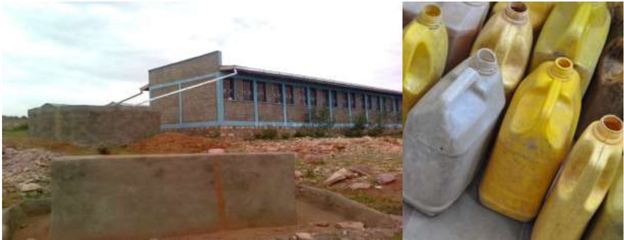
Dachwasser-Sammelinfrastruktur mit Reservoir in Akora und bereitstehende Wasserkanister im Schulzimmer (Foto: ADCS)
