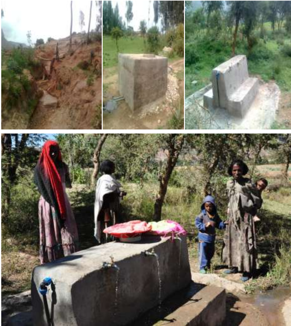
Quellfassung von Akora mit Reservoir und Zapfstelle (Foto: ADCS/ Caritas Schweiz)
