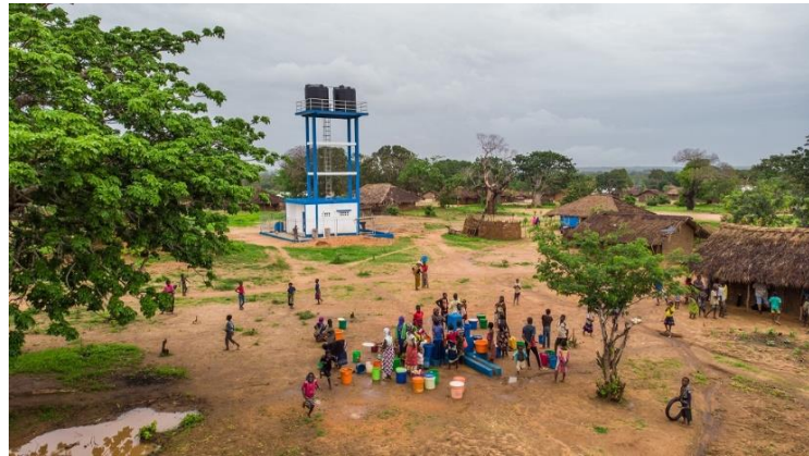
Eine mit Solarenergie betriebene Pumpe fördert sauberes Wasser aus dem Bohrloch in zwei grosse Behälter auf dem Wasserturm. Von dort aus fliesst es zu den im Dorf verteilten Zapfhähnen. Die Wasser- und Hygienekommission von Hurucune erhebt bescheidene Wassergebühren, mit denen sie die Kosten für Sauberkeit, den einwandfreien Betrieb, die langfristige Instandhaltung und den weiteren Ausbau der Wasserversorgung bestreitet. Foto: Helvetas / Ricardo Franco
