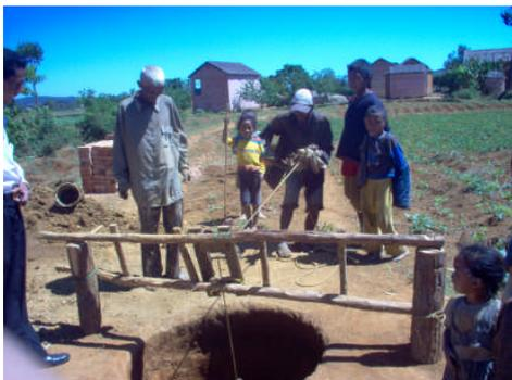
Die Brunnenwände wurden mit Ziegeln verstärkt, die Brunnen mit einer Betonplattform abgedeckt. Das überschüssige Wasser wird
