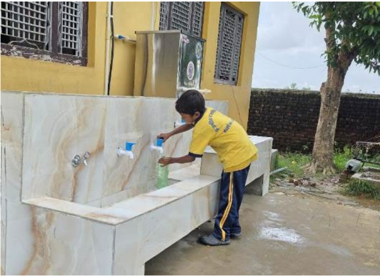
Installation d'eau potable avec fonction de refroidissement.
